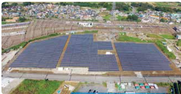
東武森林公園太陽光発電所
