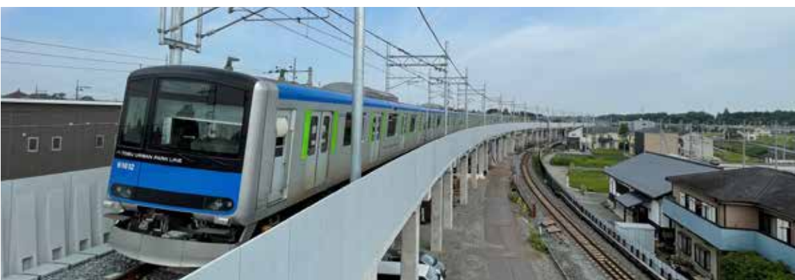
愛宕駅付近の高架橋
