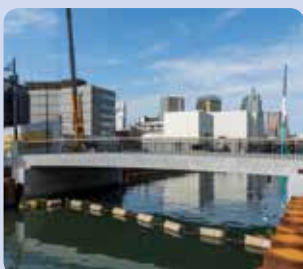
橋梁架け替え工事 (東武谷内田建設)
