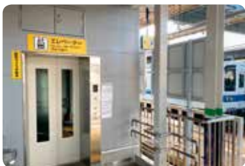
エレベーター
