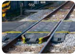
再生プラスチック製の踏切板
