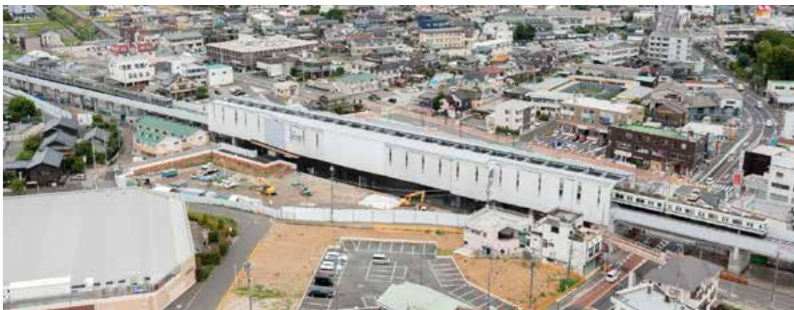
高架化した愛宕駅付近の様子
